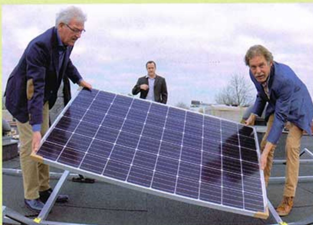
Har Geenen (voorzitter Leudal Energie) en Arno Gubbels (directeur Spolt) leggen het eerste paneel op het dak van basisschool De Neerakker.
